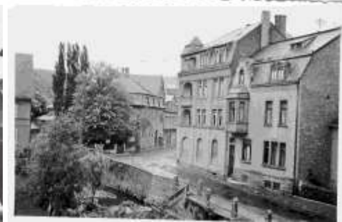
Schützenstr. 2 und 4, Höckelbösch- str. 1
