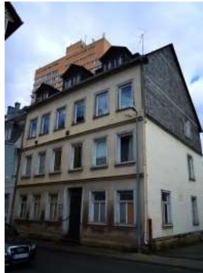
Höckelböschstr. 4, 2014 Foto: G. Purper
