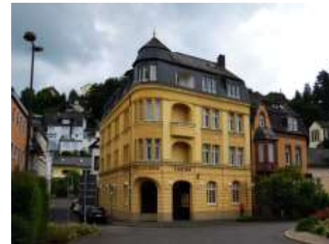
Höckelböschstr. 1, 2014 Foto: G. Purper
