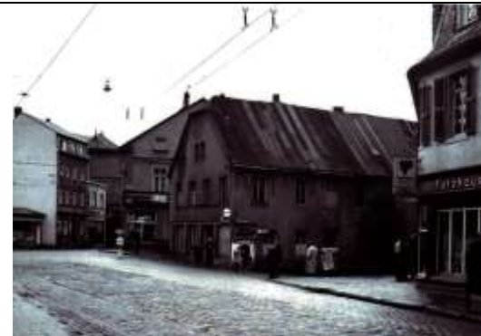
Hauptstr. 35, 38 bis 42, Brunnengasse 2 Quelle: Stadtarchiv Idar-Oberstein Foto: Reusse
